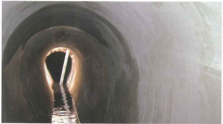
Übergang EI 800/1200 auf EI 1000/1290 mit eingebautem Konus nach der Aushärtung.
