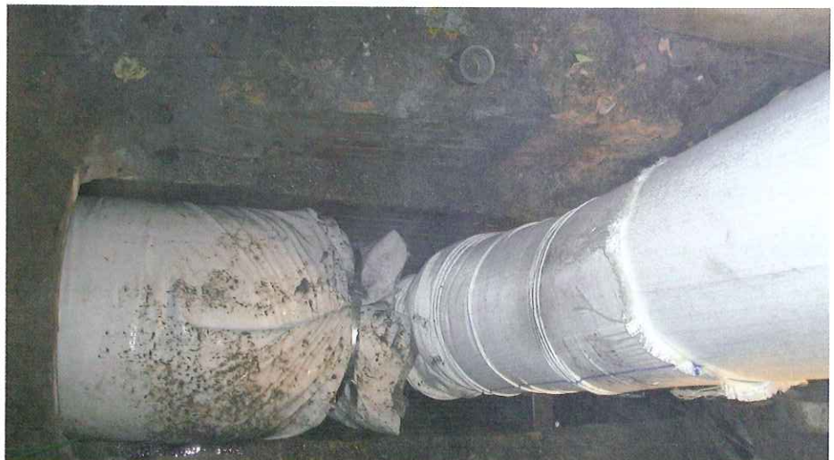
Wassersäule DN 500 mit eingebundenem Pull-Inliner.
