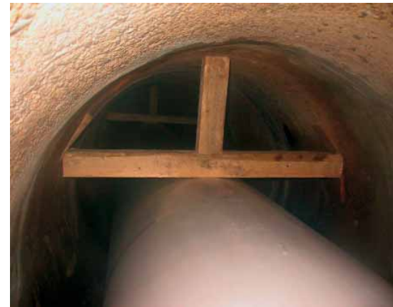
Auftriebsicherung aus Kanthölzern für „Doppelliner“ - System DN 1000 mm.
