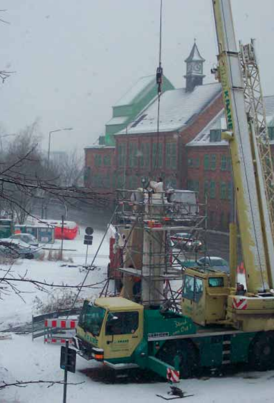
Installation „Doppelliner“ DN 1000 mm in Altröhr DN 1500 mm.
