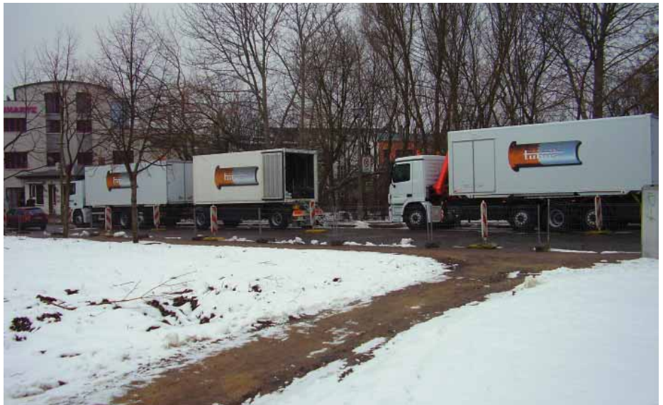
Sanierungszug zur Linerinstallation.
