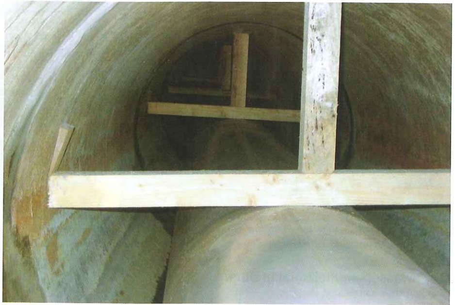
Auftriebssicherung des ausgehärteten Linersystems zur Vorbereitung der Verdämmung.
