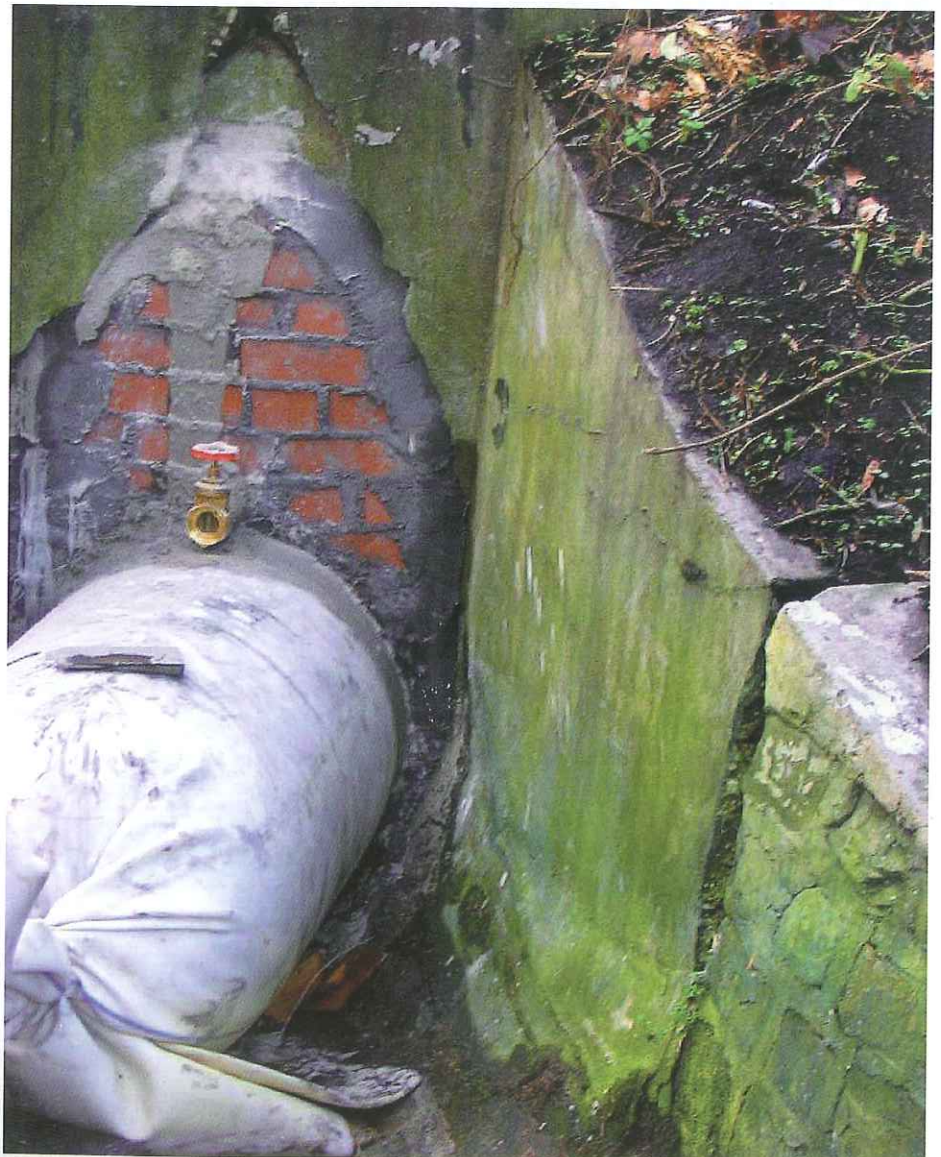
Das abgemauerte Eiprofil während des Verdämmens. | Fotos: Norditube
