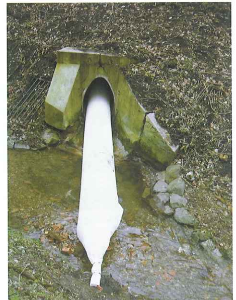
Der „Doppelliner“ tritt aus dem Auslaufbauwerk des Kanals aus.
